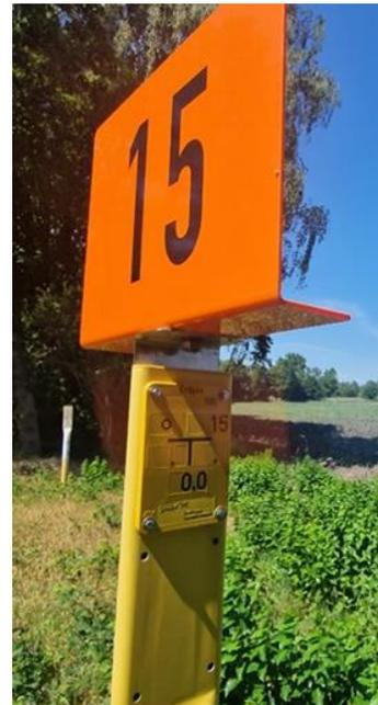
Erdgas-Pipeline mit Markierungssignal zur Lokalisation
