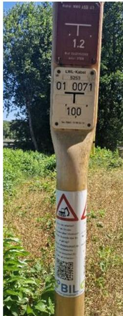
Streckenmarkierung einer Rohölpipeline (Rot) mit parallel verlegtem LWL-Datenkabel (Gelb)
